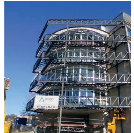
Der Abschnitt „Baustufe 1“ war der Anfang des umfassenden Aktionsplanes im LKH Wolfsberg
