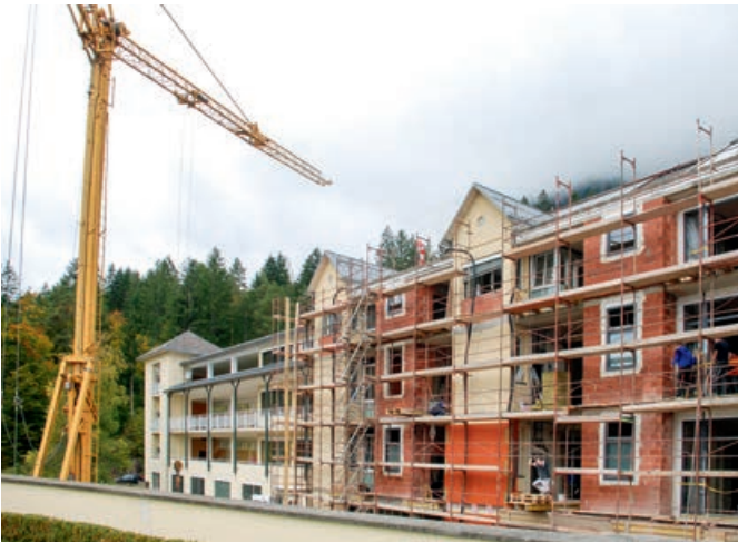
Umbau der Sanitärzellen im LKH Laas
