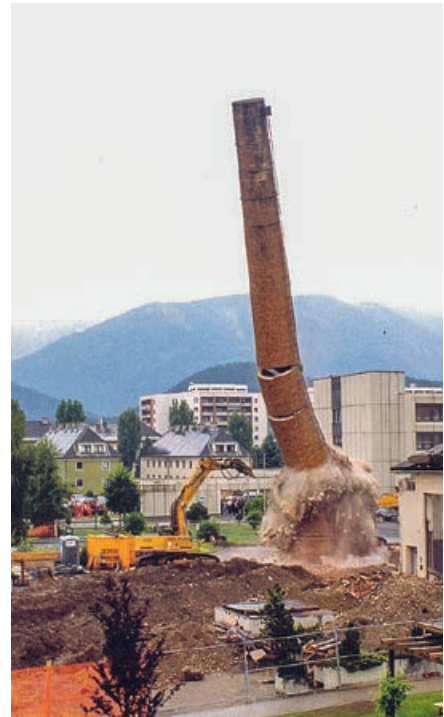
Kaminabbruch im Zuge der Neugestaltung der Parkplätze und Grünflächen im LKH Villach
