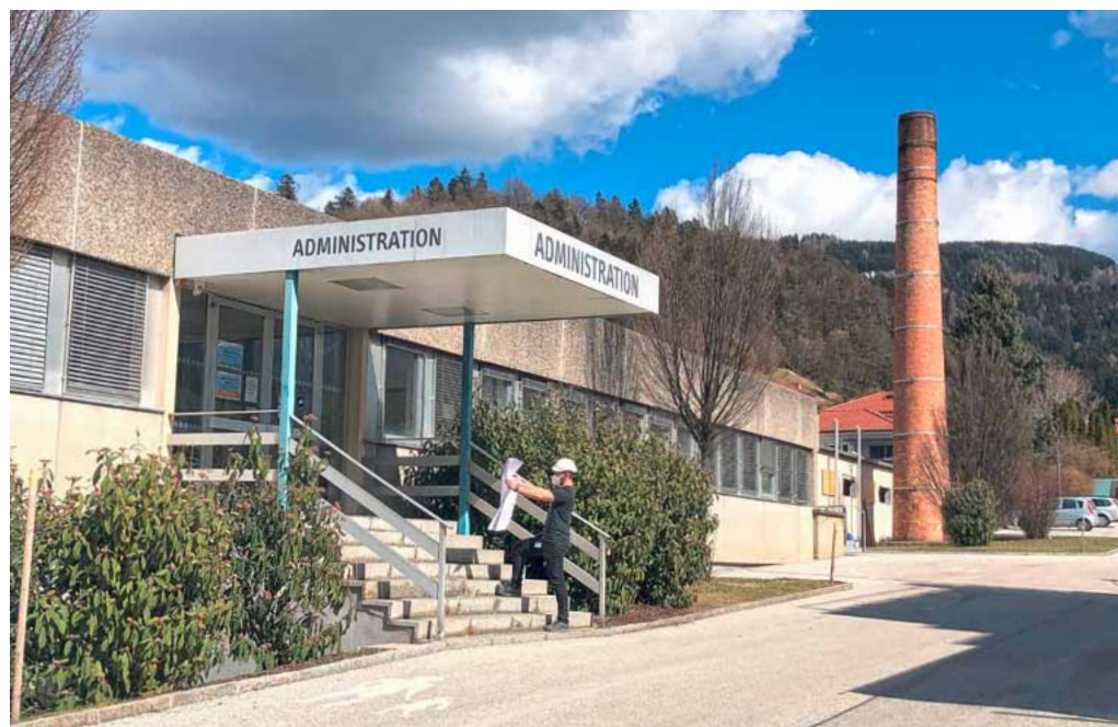
Die Treppe zum Verwaltungsgebäude und der aus Backstein bestehende Schlot werden abgerissen.
