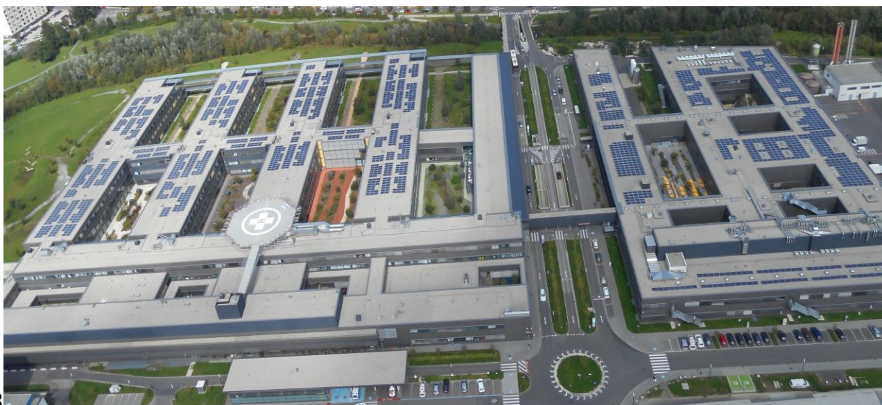
Bild 2: PV Anlage 570 kWp Klinikum Klagenfurt
