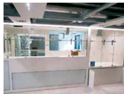
Die Arbeiten im Neubau West sind schon weit fortgeschritten.
