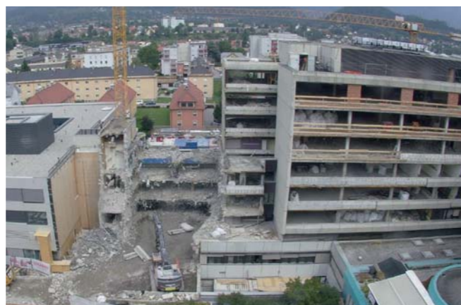
LKH Villach, Haus B – Abbruch- und Entkernungsarbeiten
