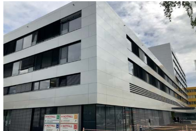
LKH Villach, Haus B – nach Umbau
