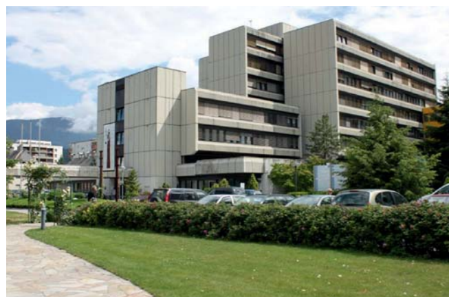
LKH Villach, Haus B (Baustufe 1) – vor Umbau
